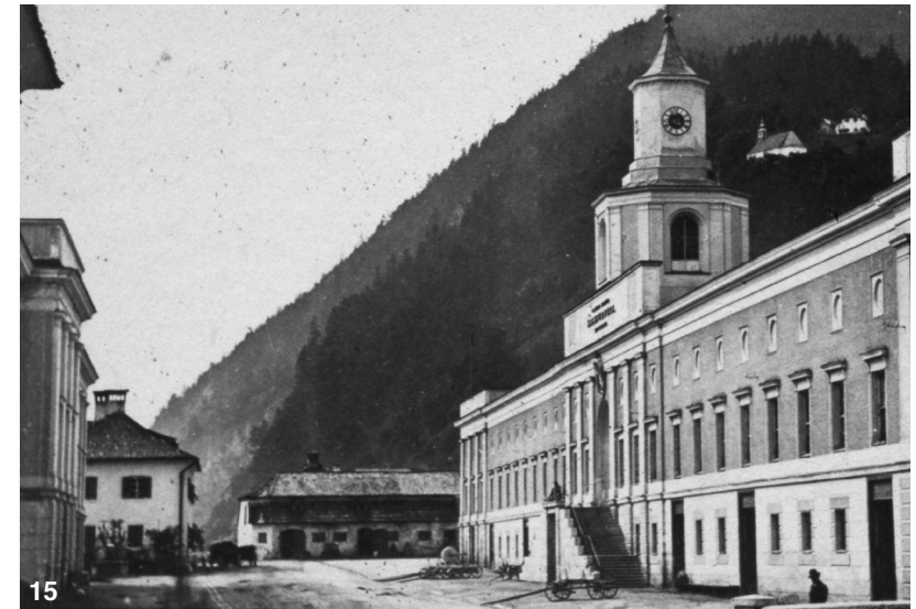
15 Metternich - Lobkowitz Werk Blick Richtung Kaiserbrücke.
