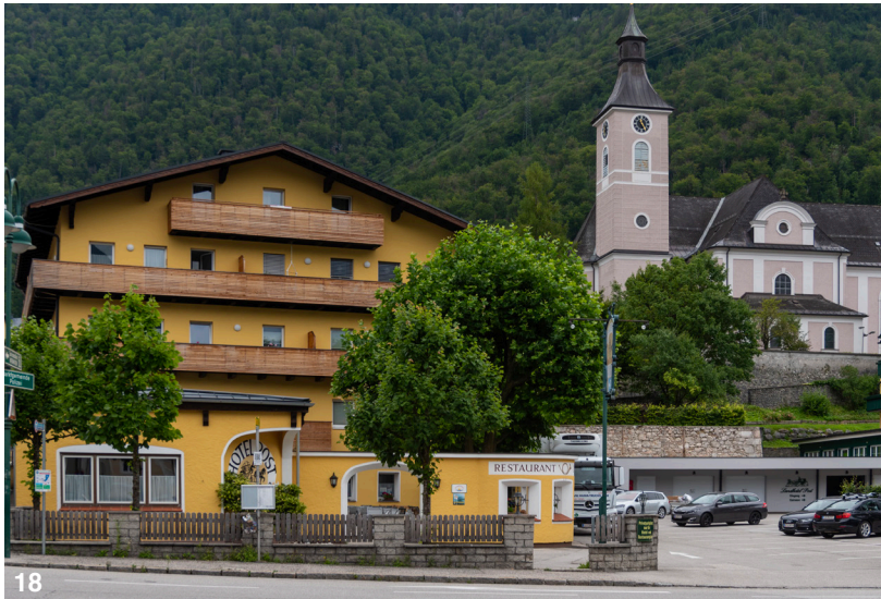
18 Heutige Ansicht des Hotel Post. Durch den Abriss der Saline wurde der Blick zur Kirche freier.
