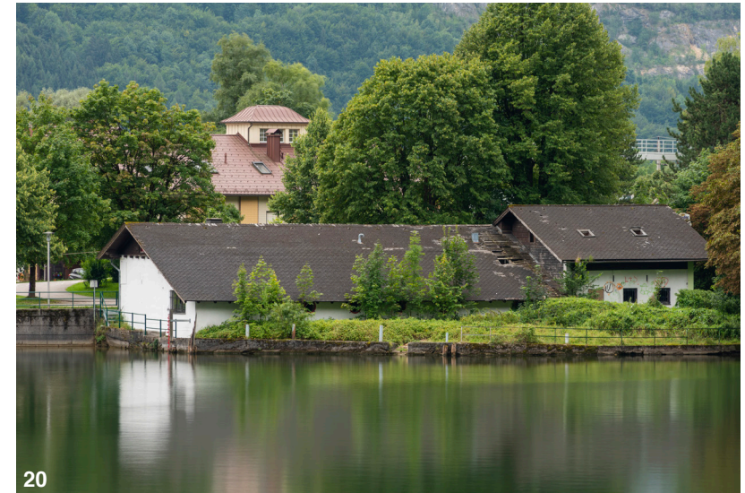
20 Leerstehende Kegelhahn, errichtet in den 1980er-Jahren.
